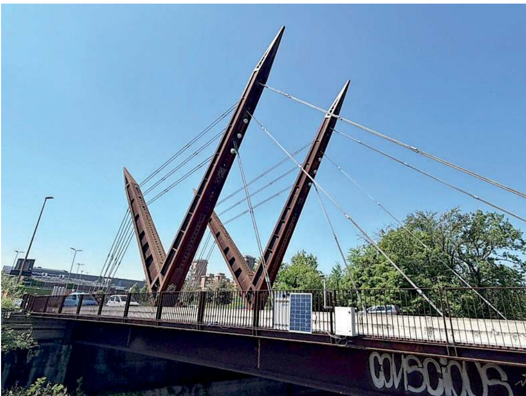
Sul ponte di via Livorno sono state sistemate le centraline che dialogano con la centrale di controllo
